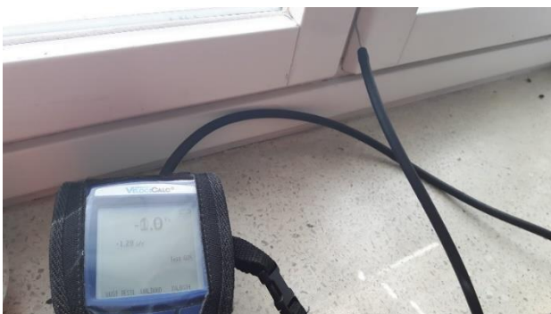
Kuva 56. Paine-eron mittaus kapillaarikoukulla tuuletusikkunan yli [Antti Alanko]
