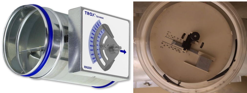
Kuva 19. Vakiovirtaussäätimen säätömekanismeja. [Vas. Trox RN, oik. Halton ASA]
