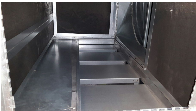
Kuva 17. Ilmanvaihtokoneen kulmaäänenvaimentimen liitos tehty liian ahtaaksi, eikä puhallin pystynyt tuottamaan mitoitettua ilmavirtausta.
